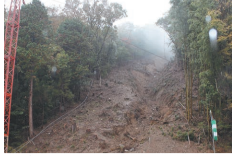
大型ダンプ約10万台分の土砂が町内に流出した災害現場
